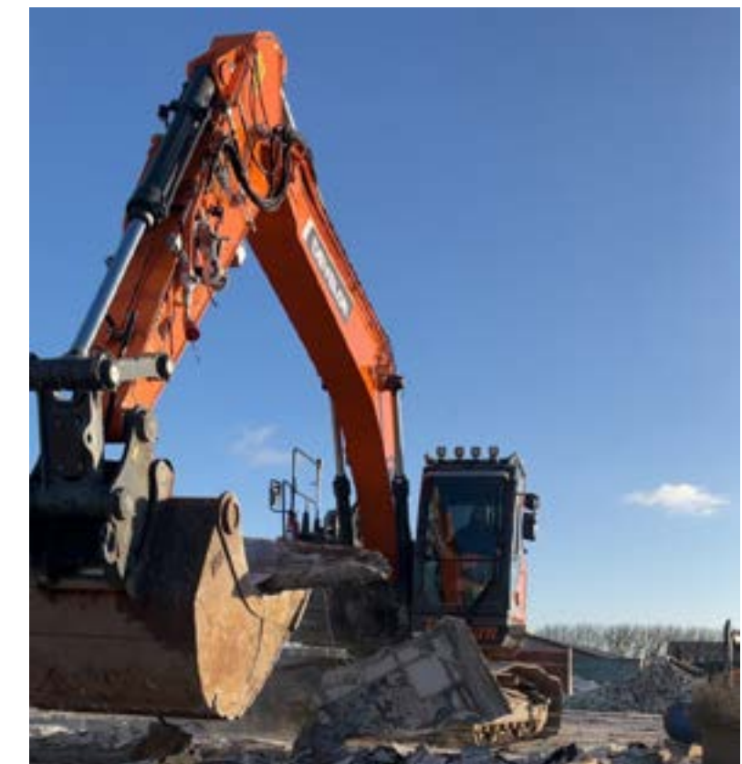
Rivning av betongolv pågår
