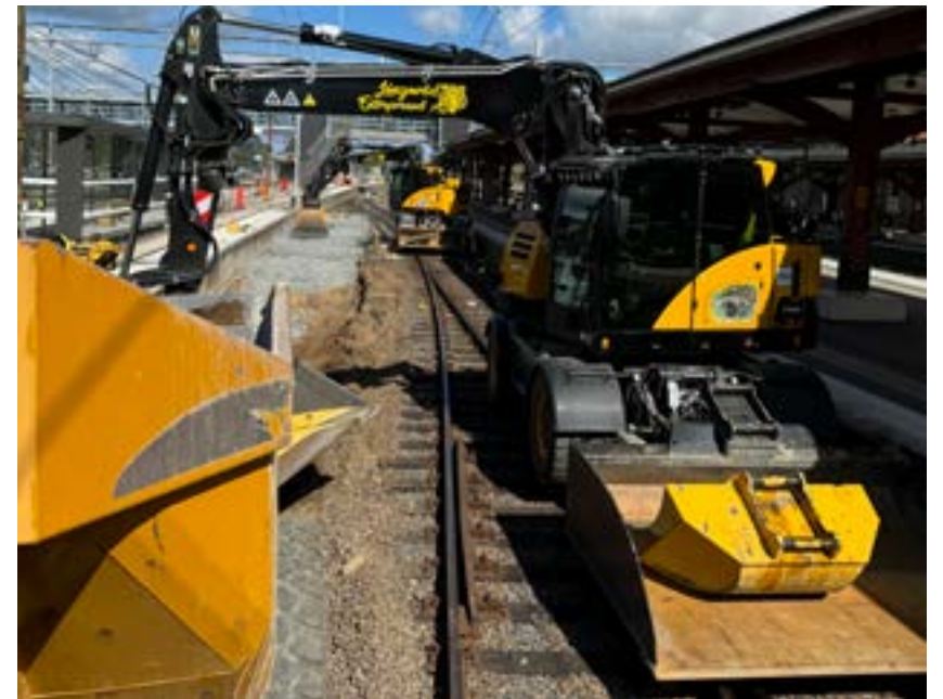
Schakt inför nytt spår pågår
