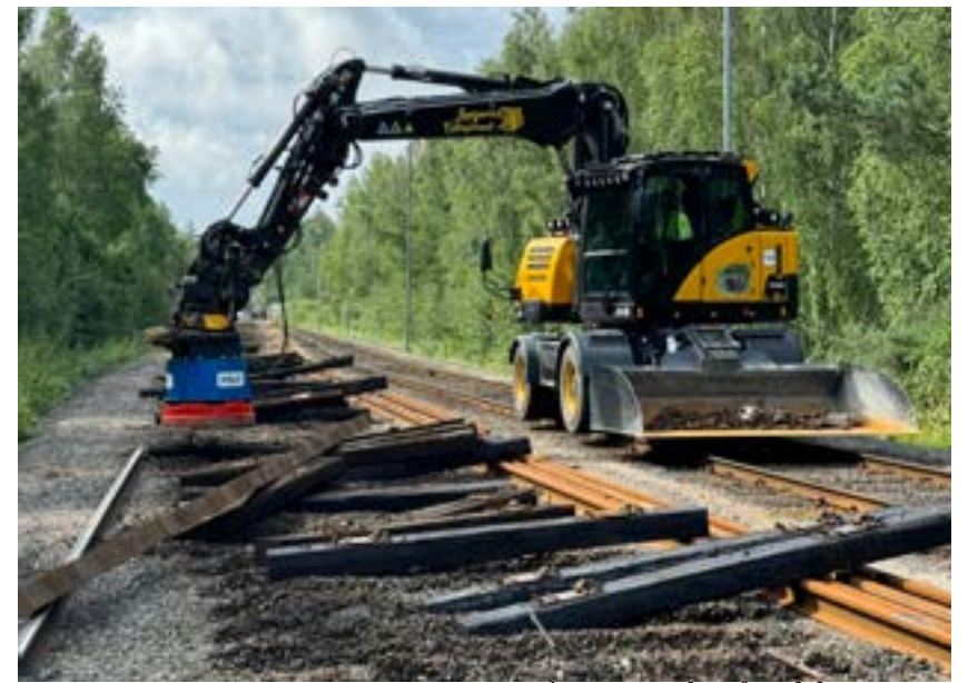
River gammalt spår och bygger nytt
