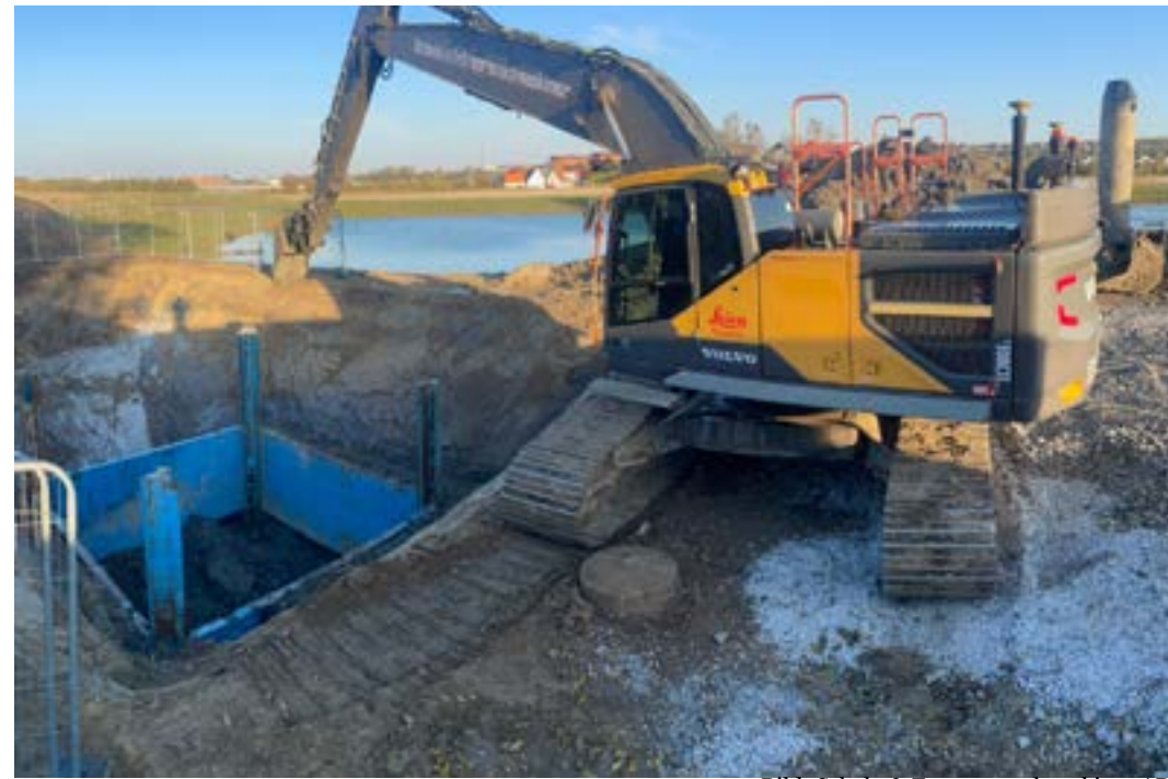
Bild: Schakt &amp; Entreprenadmaskiner AB.
