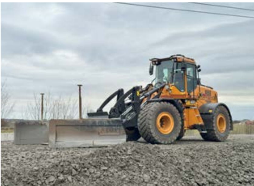
Schaktning med hyvelutrustad hjullastare som styrs av både GPS och totalstation.
