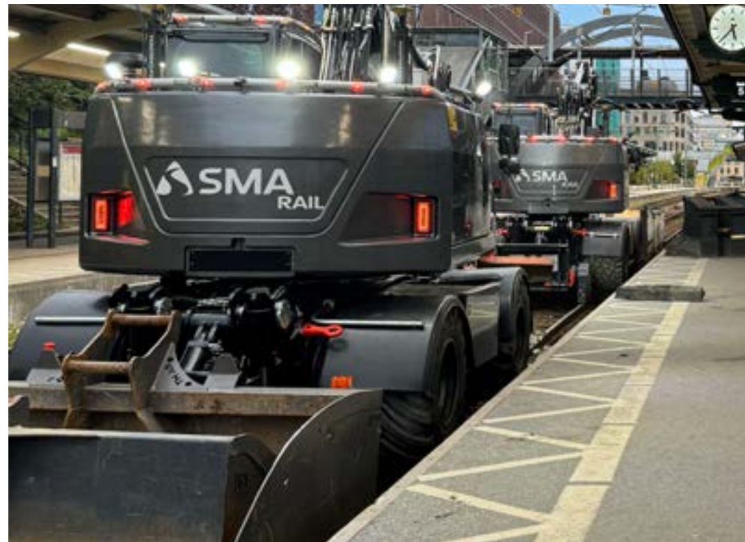
Slipersbyte åt Strukton. Bild: SMA Rail AB
