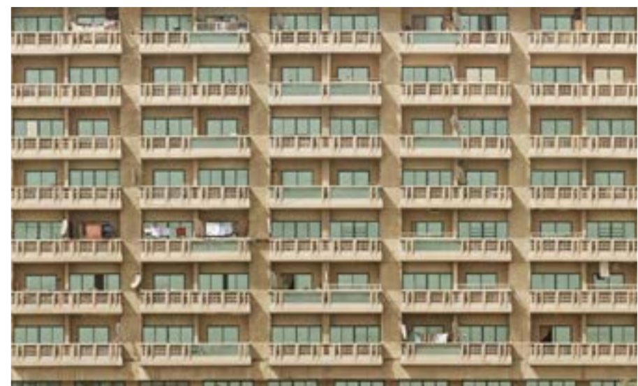
Många människor i Sverige bor i hyresrätter som är byggda mellan 1950 och 1975. Men byggnaderna är gamla och håller nu på att renoveras för att de är slitna, och för att minska energianvändningen. Foto: Pixabay
